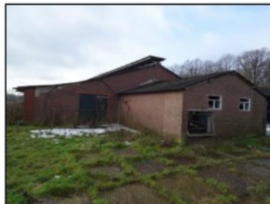
Figuur 5. Te slopen veestal.
