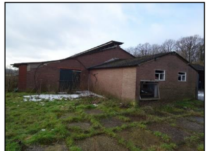
Figuur 5. Te slopen veeststal.
