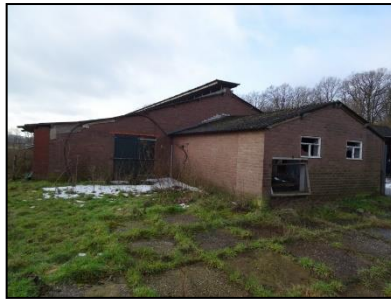
Figuur 7. Noordzijde ligboxenstal met aanbouw (E).
