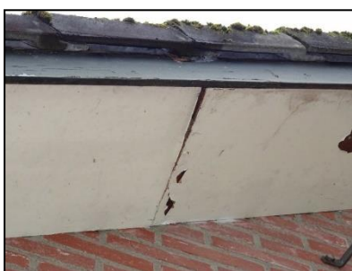
Figuur 29. Ruimte onder dakpannen westelijke dakrand bungalow.
