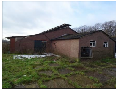
Figuur 7. Noordzijde ligboxenstal met aanbouw (E).
