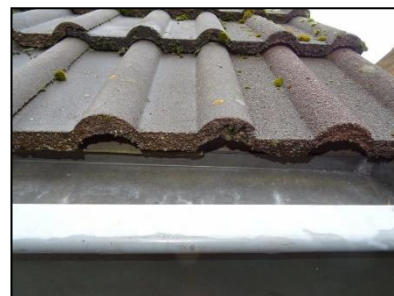
Figuur 15. Ruimte onder dakpannen bungalow.
