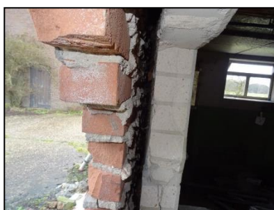
Figuur 30. Open spouwmuur werktuigenberging.
