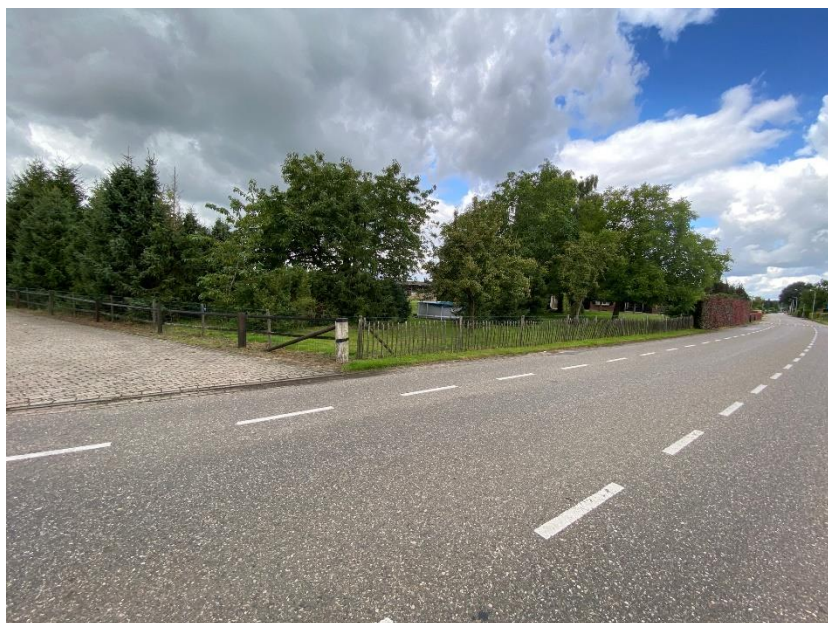
Figuur 3 “Straatzijde vanuit oostelijke richting”
