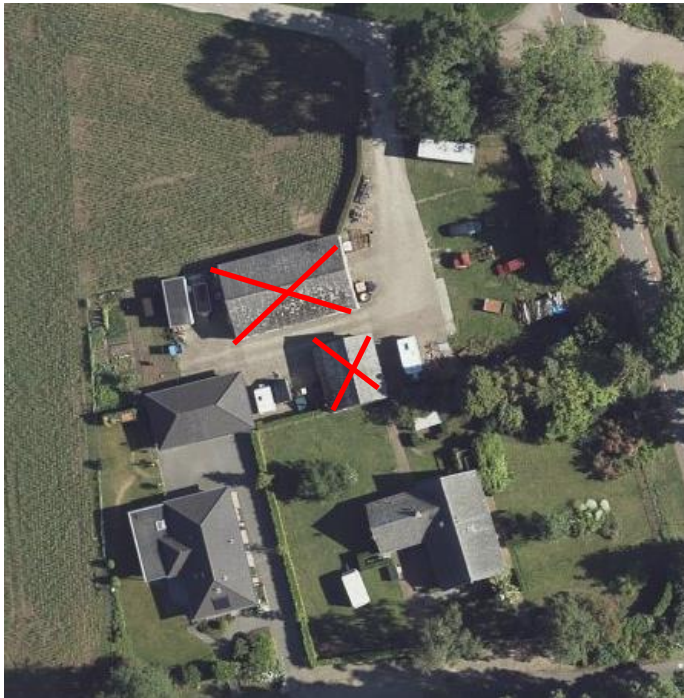
Afbeelding 8: uitsnede luchtfoto met daarop de te slopen gebouwen.
