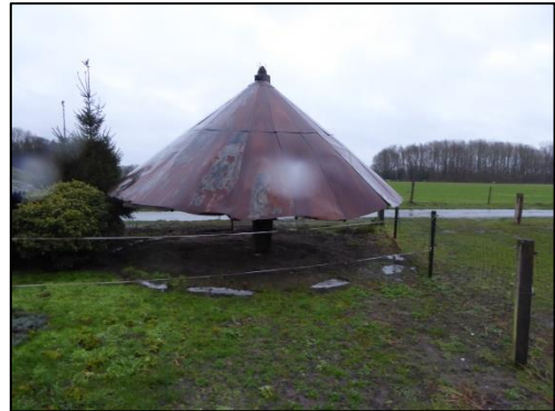
Het te slopen afdak;
