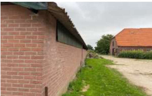
Figuur 17: Aanwezige onverharde afwateringzone
