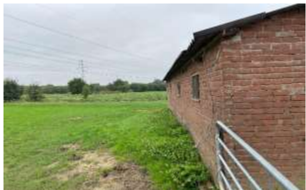
Figuur 18: Aanwezige onverharde afwateringzone
