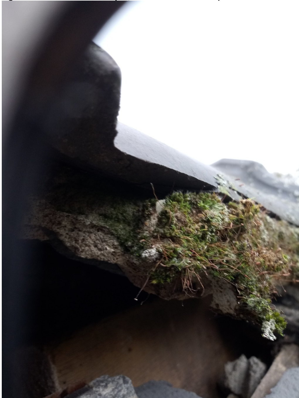
Figuur 2. Situatie onder de nokpan, na het liften van de nokpan.
