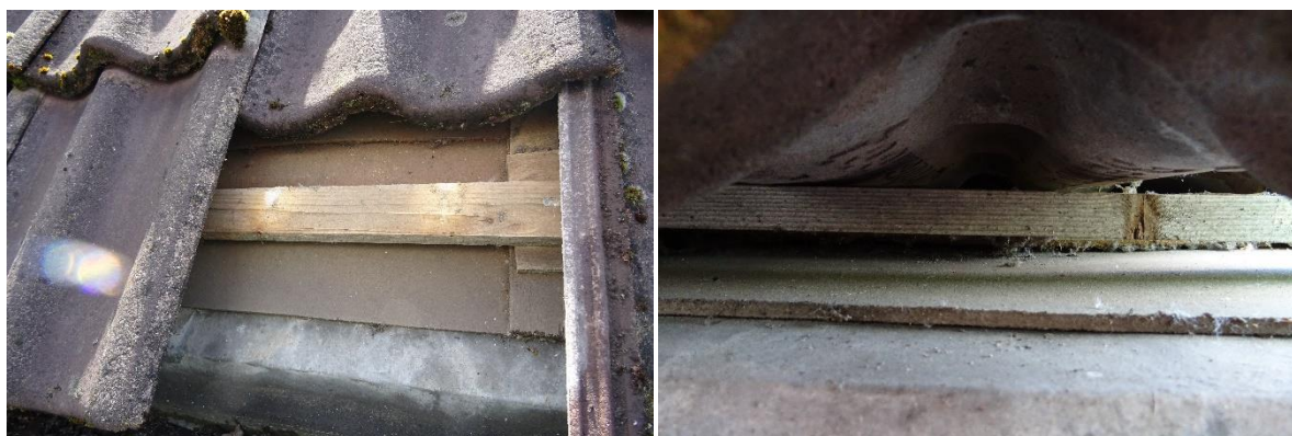
Afbeelding 11 en 12: Dak woonhuis onderzocht op de mogelijk aanwezigheid van huismussen. Huismussen of sporen van huismussen zijn niet aangetroffen. Bron: R.J.L. Bijvelds 15-07-2020
