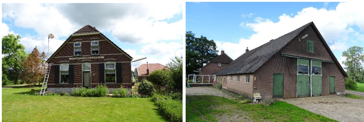
Afbeelding 4 en 5: Het bestaande woonhuis welke in de komende jaren verbouwd/ herbouwd gaat worden. Bron: R.J.L. Bijvelds. Datum: 15-07-2020
