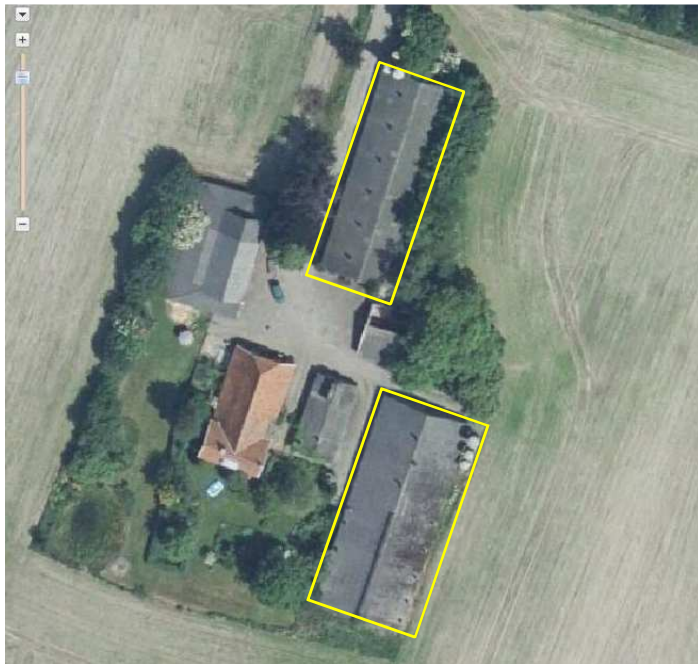
Detailweergave van het deelgebied. De te slopen bebouwing wordt met het gele kader aangeduid. (Bron luchtfoto: PDOK).
