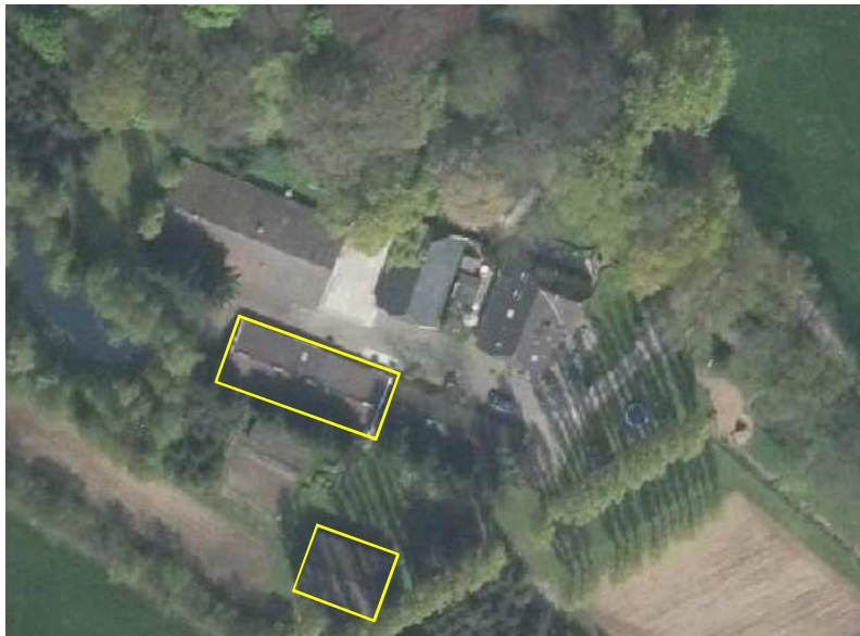
Detailweergave van het deelgebied. De te slopen bebouwing wordt met de gele kaders aangeduid. (Bron luchtfoto: PDOK).
