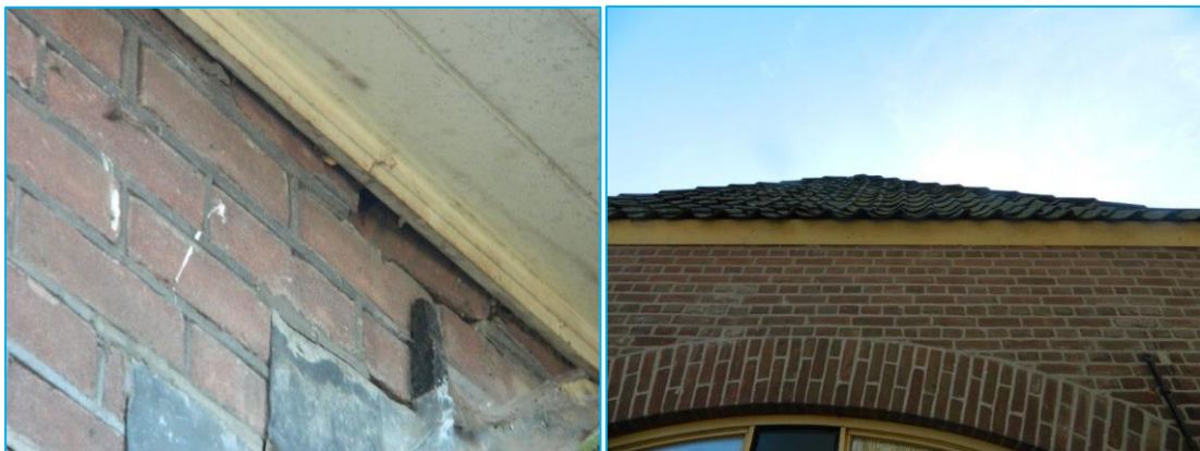
Foto's: Geschikte openingen naar potentiële verblijfplaatsen van vleermuizen.
