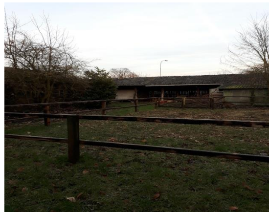
Figuur 9: Dak(goot) bebouwing
