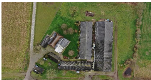
Figuur 13: Overzichtsfoto onderzoekslocatie
