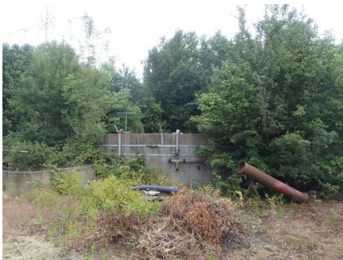
Foto 6: de oude mestsilo grotendeels door opgaande beplanting overwoekert.
