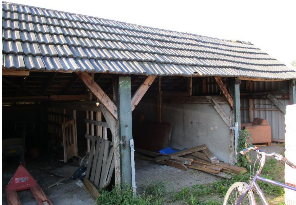
Figuur 3 De open kapschuren hebben gemetselde muren en pannendaken zonder dakbeschot. Er is in de aanwezige bebouwing op het perceel geen potentie voor huismussen, gierzwaluwen en vleermuizen.
