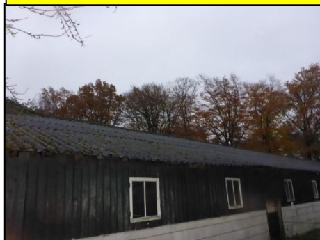
Schuur 1: Golfplaten dak (M01AZ)
