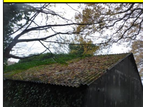
Schuur 4: Golfplaten dak (M08AA)
