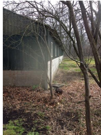
Figuur 9: Overzichtsfoto bebouwing
