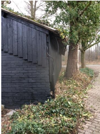
Figuur 8: Overzichtsfoto bebouwing
