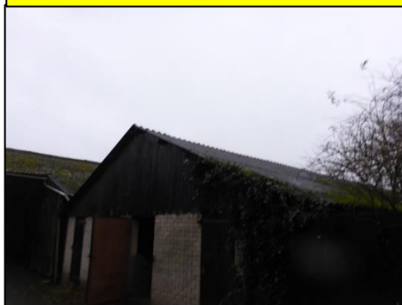
Schuur 2: Golfplaten dak (M04AA)
