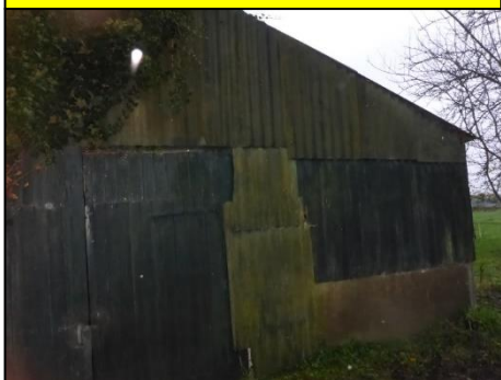
Schuur 1: Golfplaat (M01AA)
