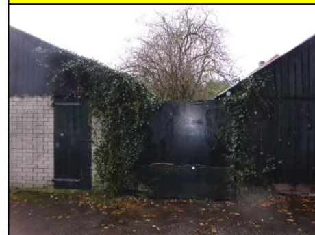
Tussen schuur 2 en 3: Vlakke plaat (M07AA)
