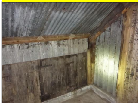
Schuur 3, gevel: Golfplaten (M06AA)
