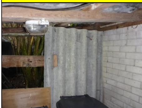
Schuur 2, gevel: Golfplaat (M04AZ)
