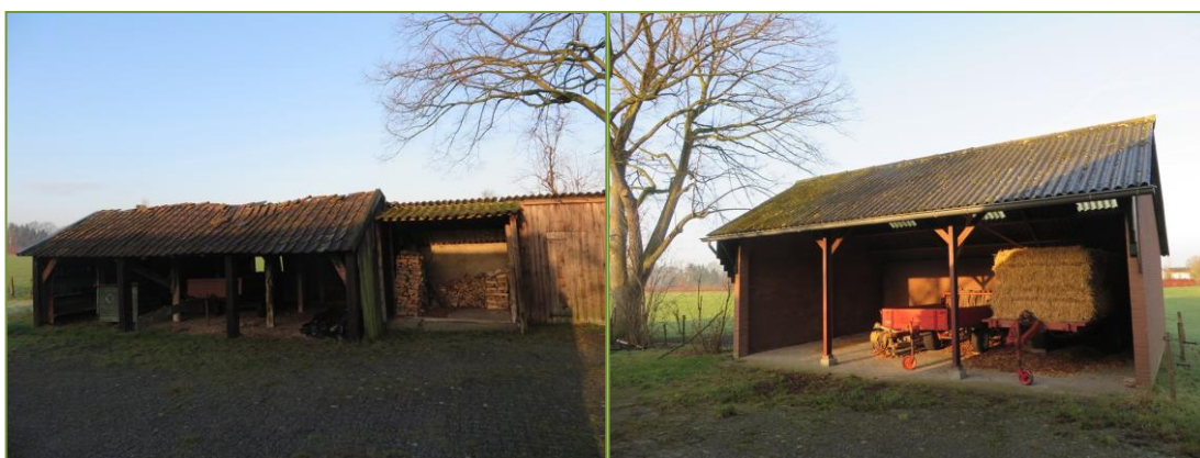
Foto's: Indrukken te amoveren schuur en kapschuur.
