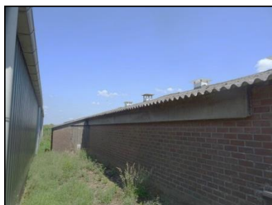
Figuur 6. Westgevel van te slopen grote schuur.
