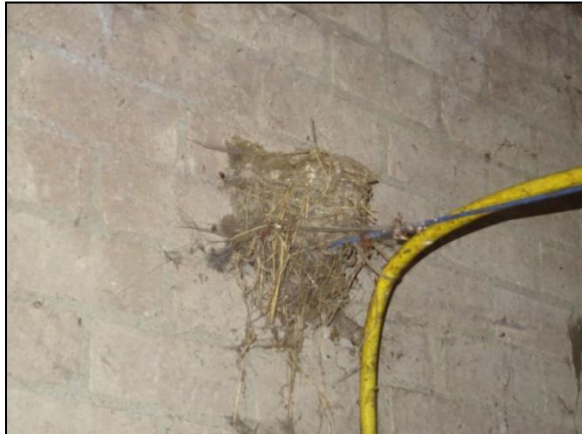
Figuur 10. Boerenzwaluwnest tegen stenen muur.
