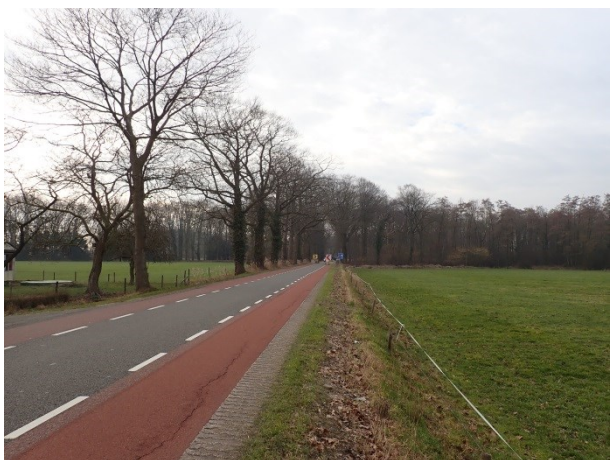
Foto 1: locatie gezien vanuit de noordelijke richting.
