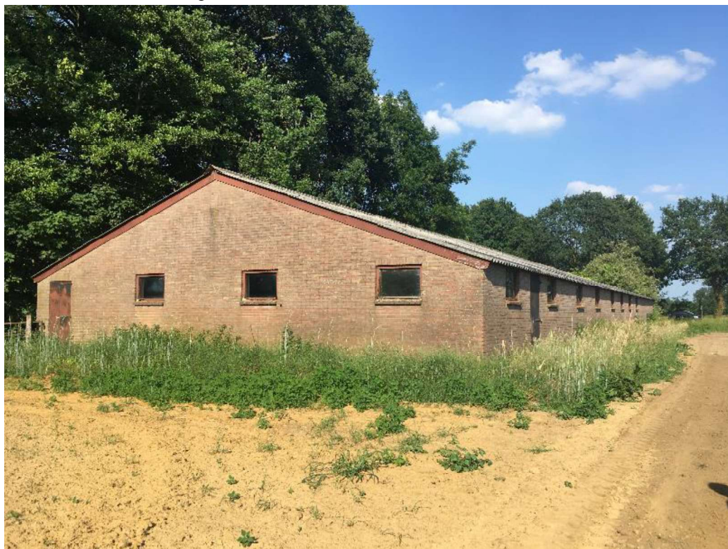
Figuur 3 De varkensschuren aan de Doetinchemseweg zijn opgetrokken uit metselwerk en dragen een asbest dak.
