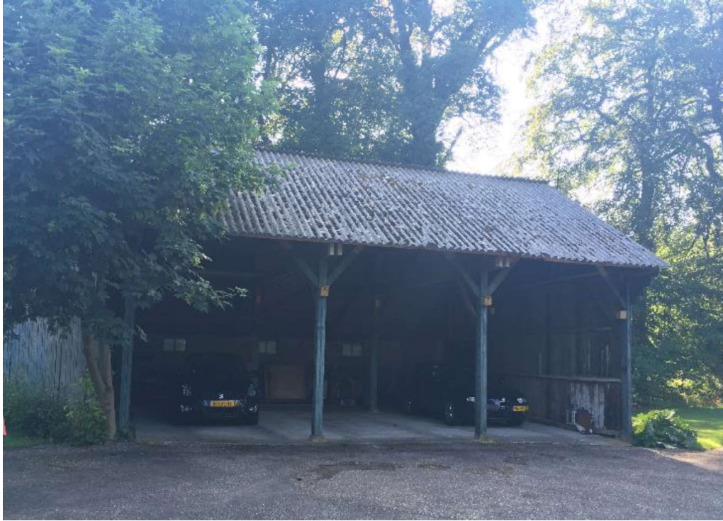
Figuur 5 Het dak van de kapschuur bestaat uit asbest platen en wordt derhalve vervangen.
