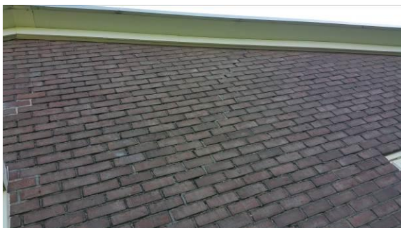
Foto 7 en 8: Gevel en gevelbetimmering kantoorruimte
