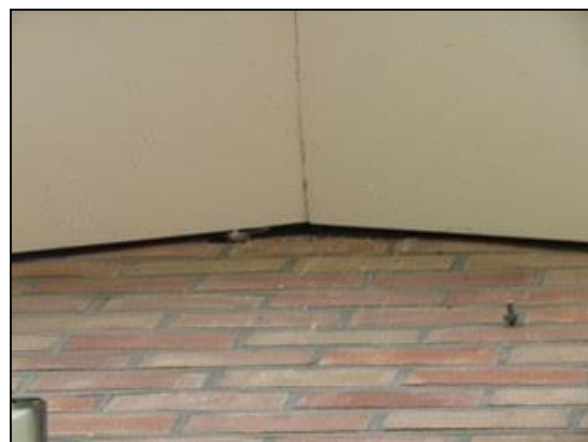
Figuur 11. Ruimte langs de dakranden biedt toegang voor de gewone dwergvleermuis.
