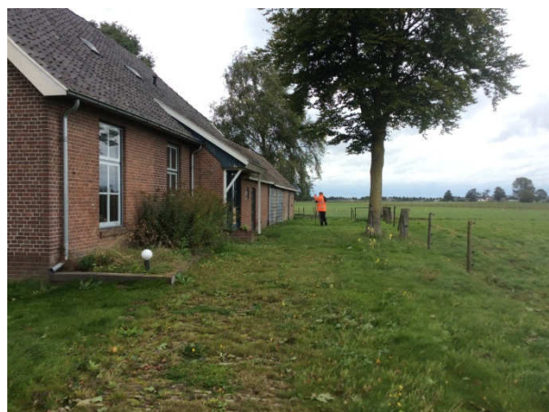
foto 4: westzijde pand met klinkerpad
