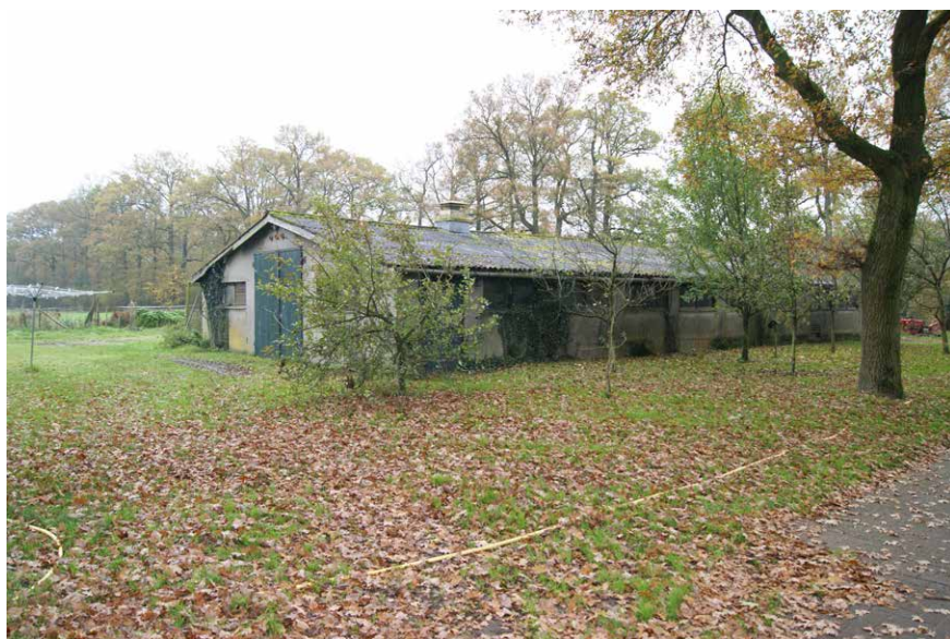
Bestaande betonnen schuur
