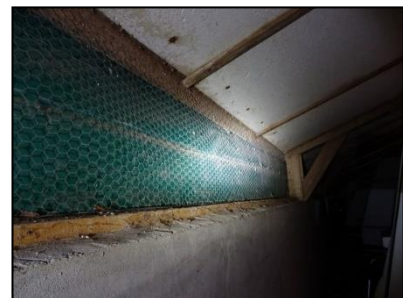
Figuur 11. De binnenzijde van de stallen is afgesloten met zeil en kippen gaas.
