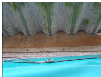
Figuur 10. Houten golfplaatvulling onder de golfplattendaken, bedoeld om vogels en zoogdieren te weren.
