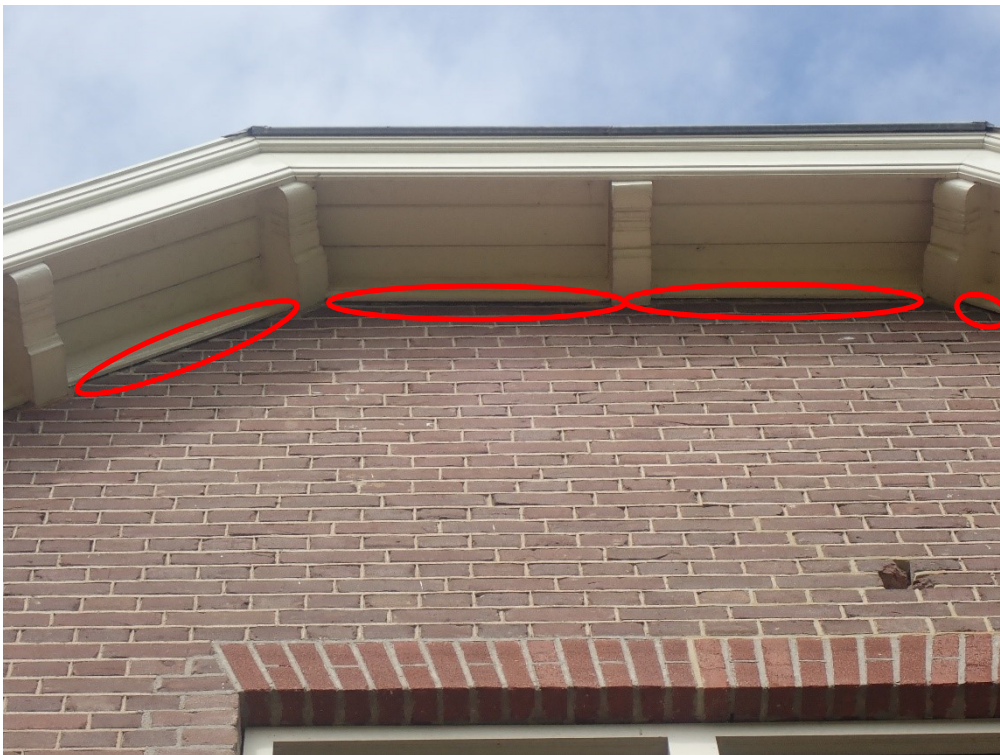
Foto 4: ruimtes achter smetplanken bieden vleermuizen toegang tot het pand
