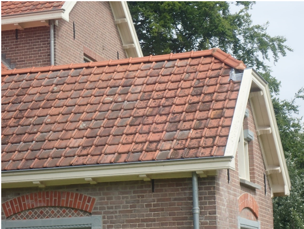
Foto 5: de ruimte onder de nokpannen (ondervorsten) is voor vleermuizen voldoende groot voor vleermuizen om hier het dak te kunnen invliegen.
