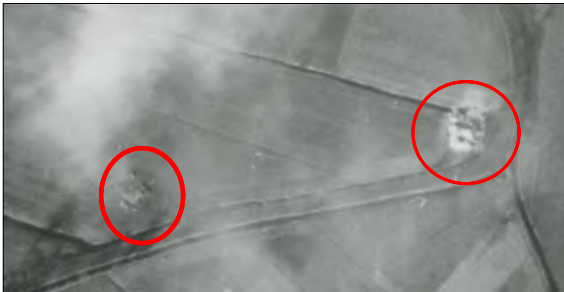
Afbeelding 4.2.2: Close-up uit luchtfoto 3251. (Geschutopstellingen in aanbouw, globaal in rood)
