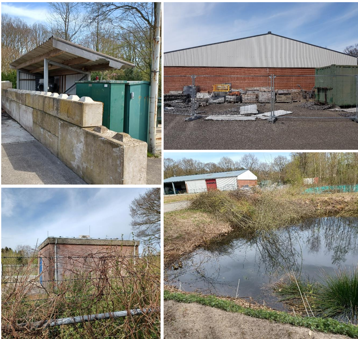
Figuur 2. Kleine open stalling (linksboven), hoofdgebouw met container en (bouw)materialen (rechtsboven), transformatorhuisje (linksonder) en een vijver met op de achtergrond het hoofdgebouw en een tweede vijver (rechtsonder).
