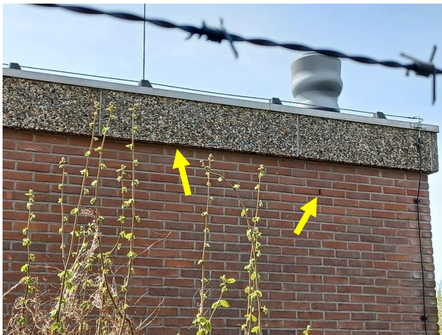
Figuur 5. Voorbeelden van potentiële verblijfplaatsen van gebouwbewonende vleermuizen in smalle openingen langs de dakrand en open stootvoegen.
