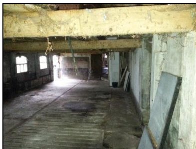
Figuur 7. Binnenzijde oostelijk gelegen bebouwing.
