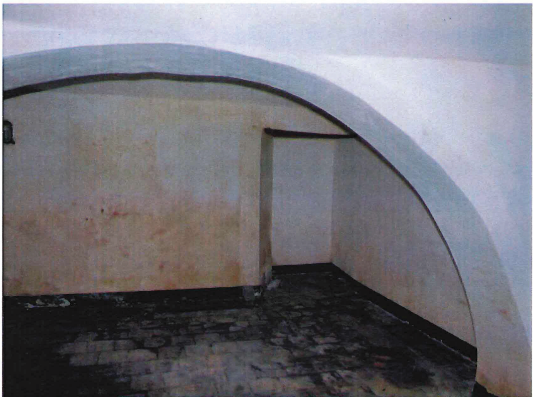
Figuur 8. ongebruikte ruimte in de kelder
