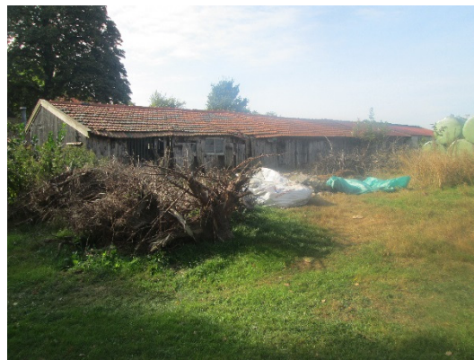
Foto 2, voormalige paardenstal ten noorden van woonhuis
