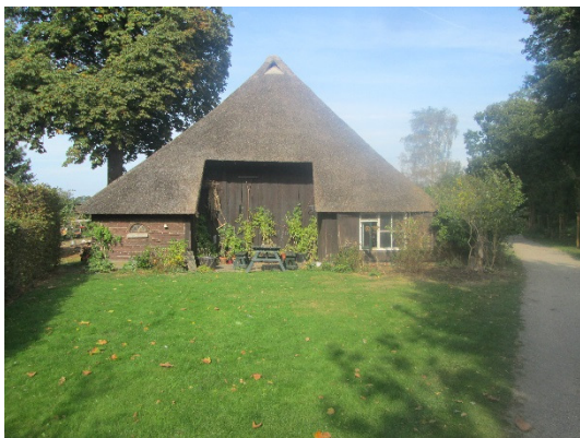
Foto 1, schuur naast woonhuis
