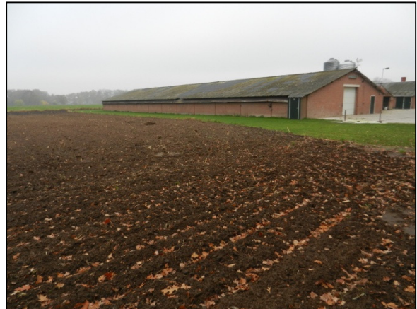
Figuur 4. De pluimveestallen.
