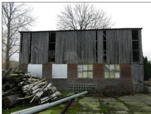
Figuur 6 te slopen kapschuur op de onderzoekslocatie.
