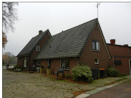
Figuur 7 Woonhuis op de onderzoekslocatie.
