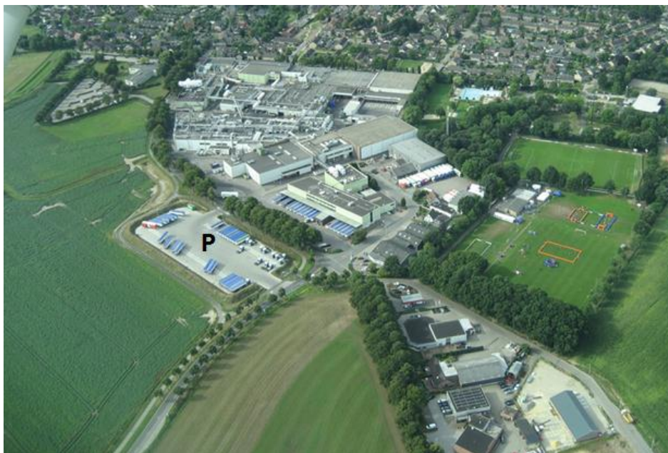
Figuur 2. Het recent aangelegd parkeerterrein aangegeven met de letter P .
