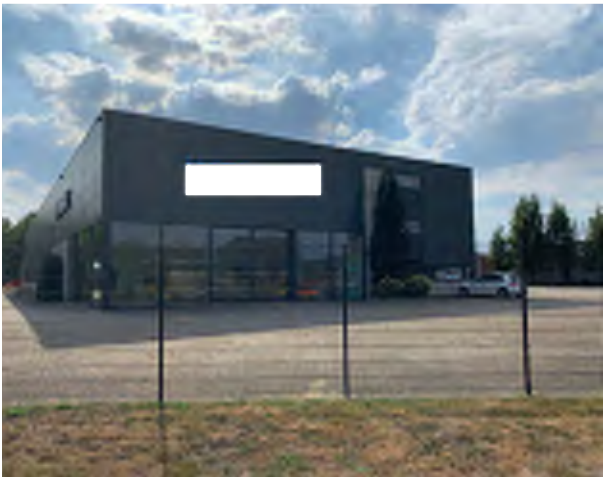
Foto: Aanzicht showroom
