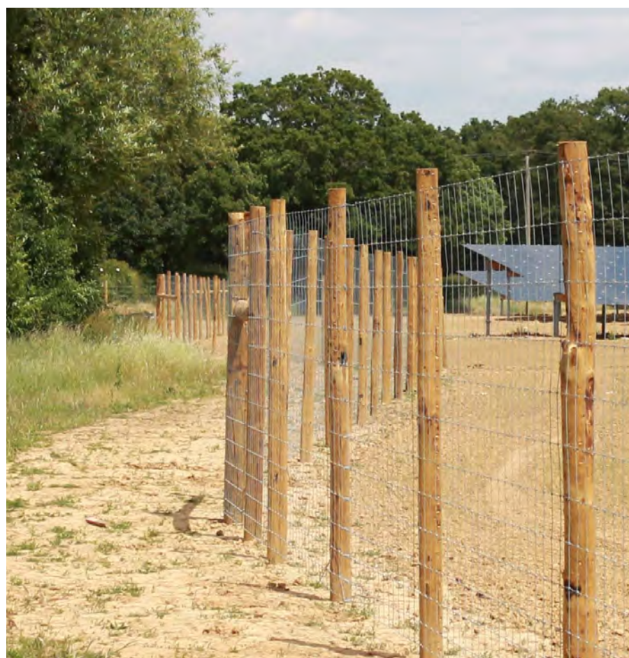
Afbeelding 13. Landschappelijk hekwerk met houten palen, schapengaas, ruimte aan onderzijde (na aanleg).
