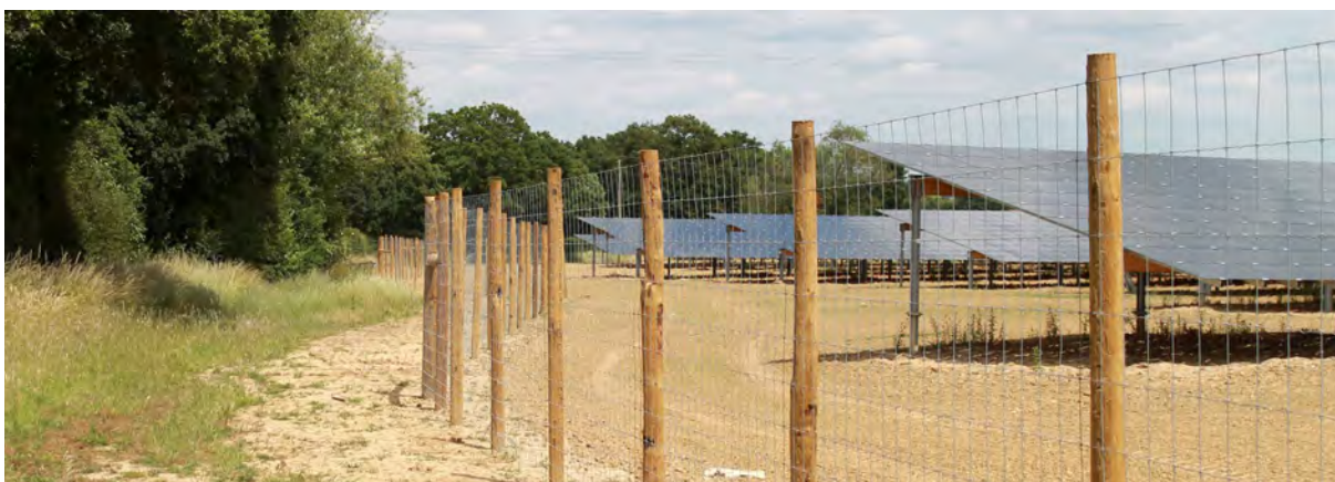
Afbeelding 40. Landschappelijk hekwerk met houten palen, schapengaas, ruimte aan onderzijde (na aanleg).
