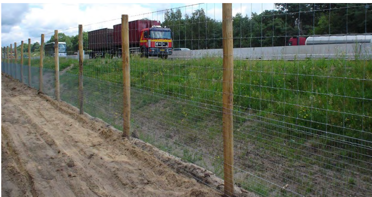
Afbeelding 41. Hekwerk N18 onderzijde (tot 100 cm) fijn gaas, 20 cm ingegraven en bovenzijde grof gaas.
