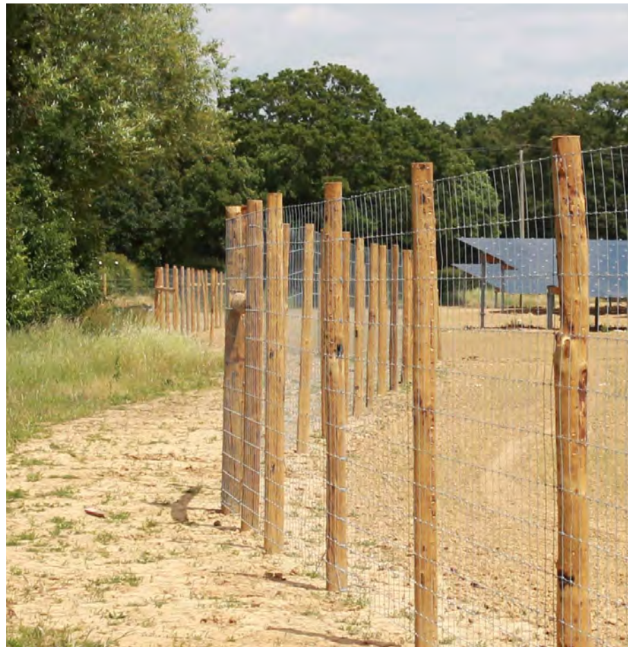
Afbeelding 13. Landschappelijk hekwerk met houten palen, schapengaos, ruimte aan onderzijde (na aanleg).
