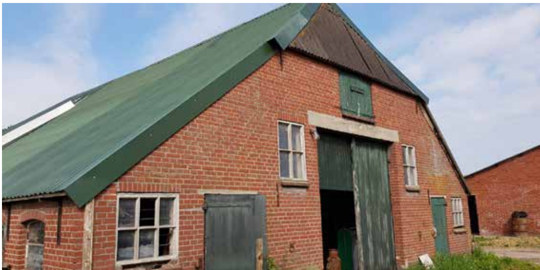
Schuur met dak van gladde (golf) dakplaten.
