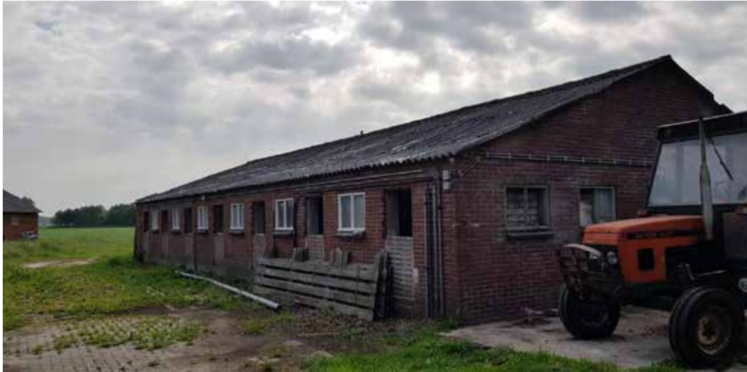
Varkensstal met dak van golfplaten.
