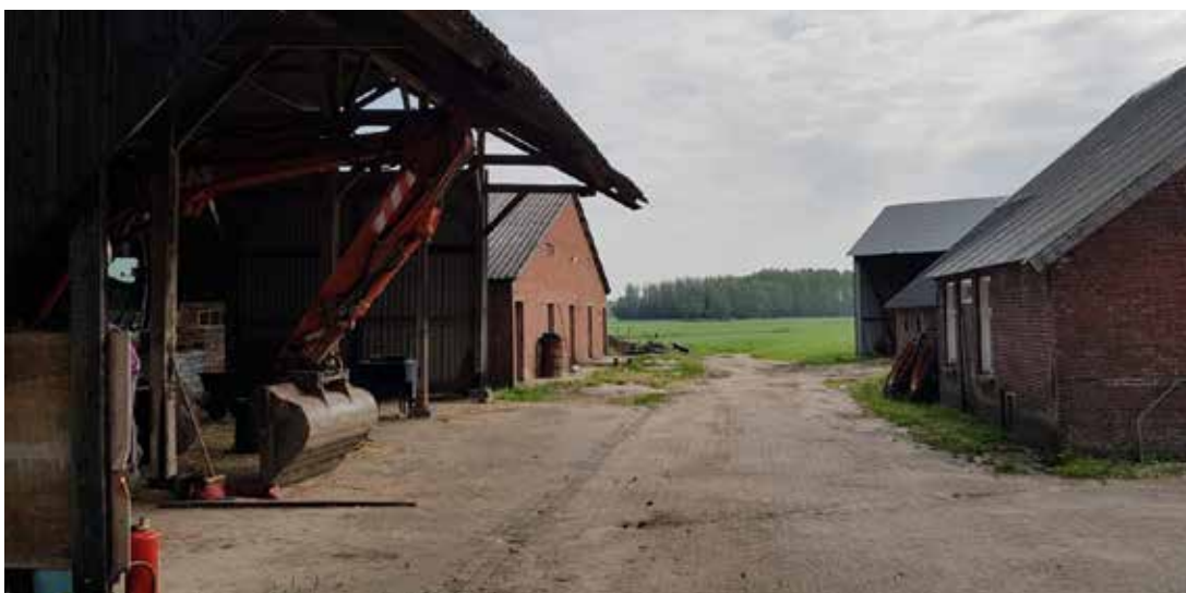
Een van de kapschuren, met open constructie.
