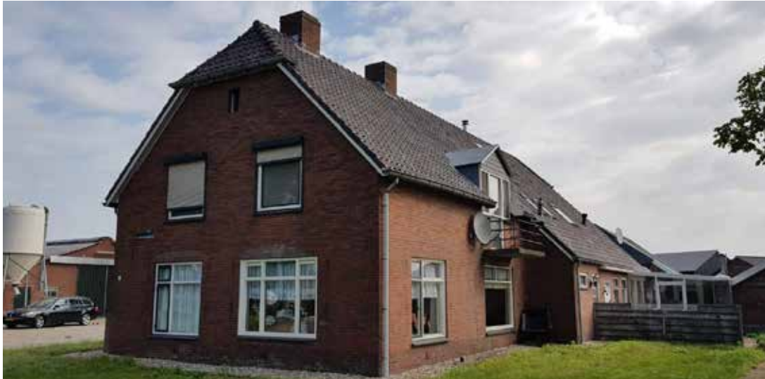
Het woonhuis met pannendak (wordt niet gesloopt)
