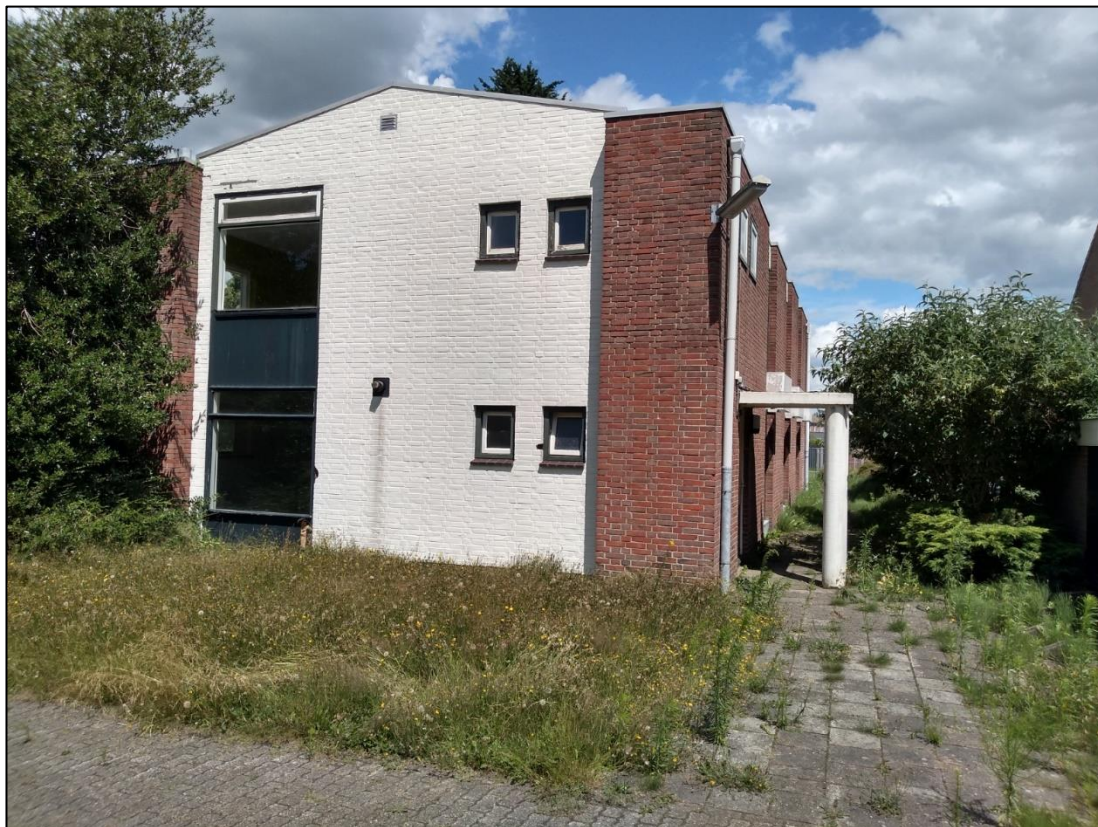
Afbeelding 17 Foto van het aanwezige te slopen kerkgebouw van de Gereformeerde Gemeente. Foto vanaf de westkant richting het oosten.
