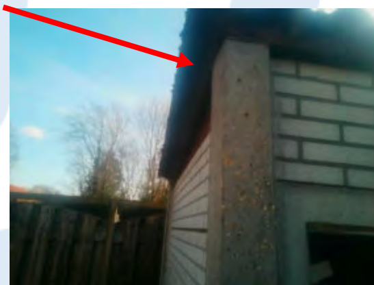
Foto 14 | Golfplaten op schuur
