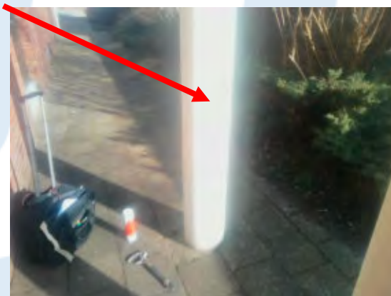
Foto 2 | Pilaren overkapping entree
