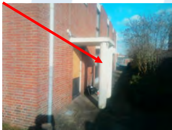
Foto 1 | Pilaren overkapping entree
