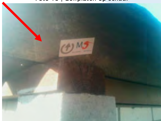
Foto 15 | Golfplaten op schuur
