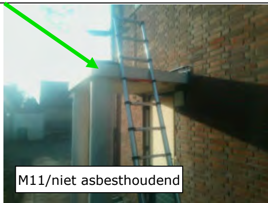
Foto 37 | Bitumen op overkapping entree
