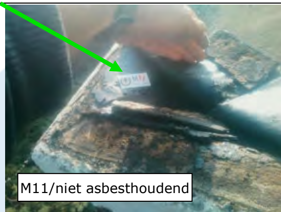
Foto 38 | Bitumen op overkapping entree
