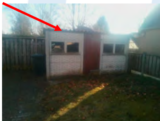
Foto 13 | Golfplaten op schuur
