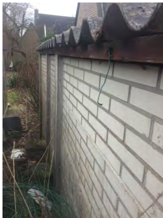
Figuur 8: Overzichtsfoto bebouwing
