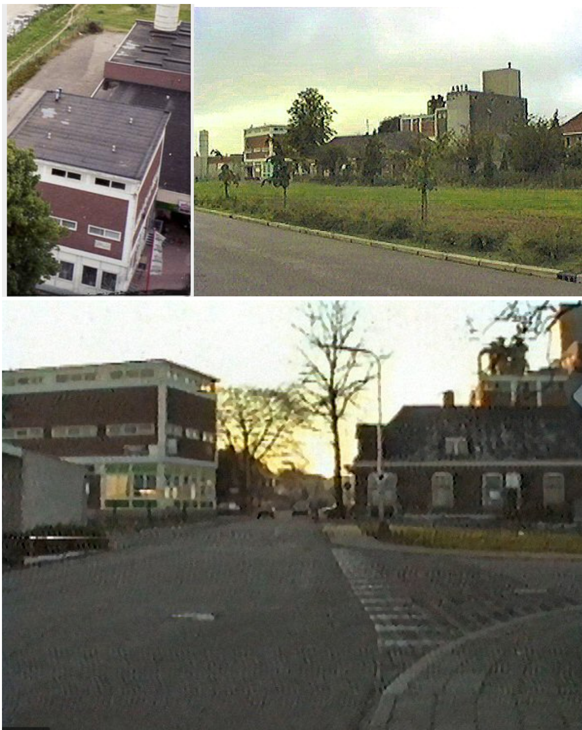
Afbeelding 5: Oude coöperatiegebouw (Bron: Raaklein architectuur)
