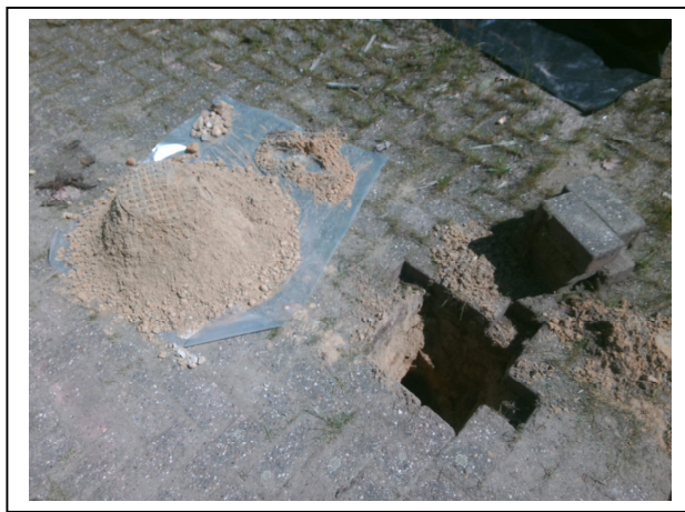
Foto 4. Asbestinspectiegat A04
