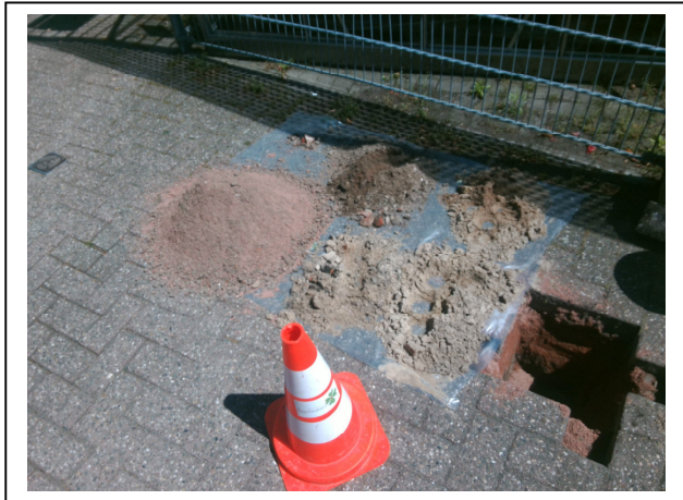
Foto 7. Asbestinspectiegat A07
