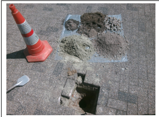
Foto 13. Asbestinspectiegat A13
