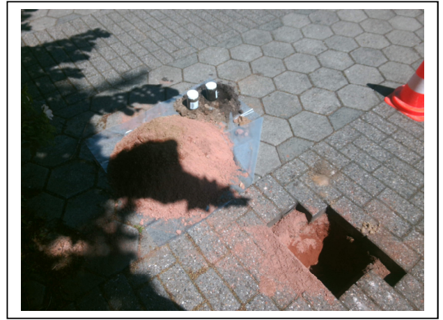
Foto 8. Asbestinspectiegat A08
