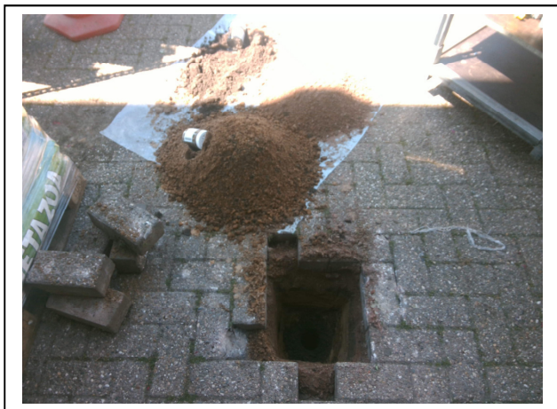
Foto 11. Asbestinspectiegat A11
