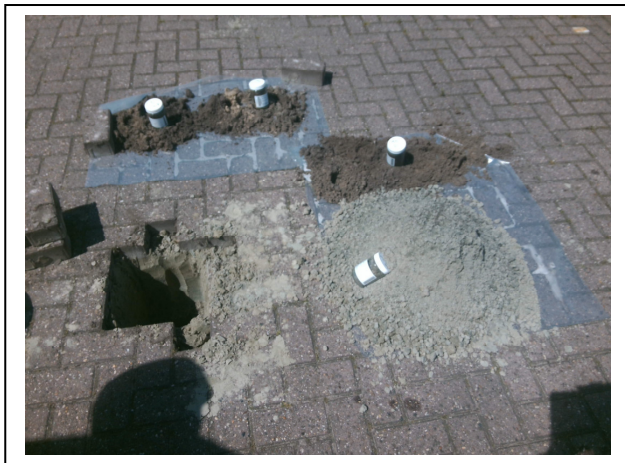
Foto 15. Asbestinspectiegat A15
