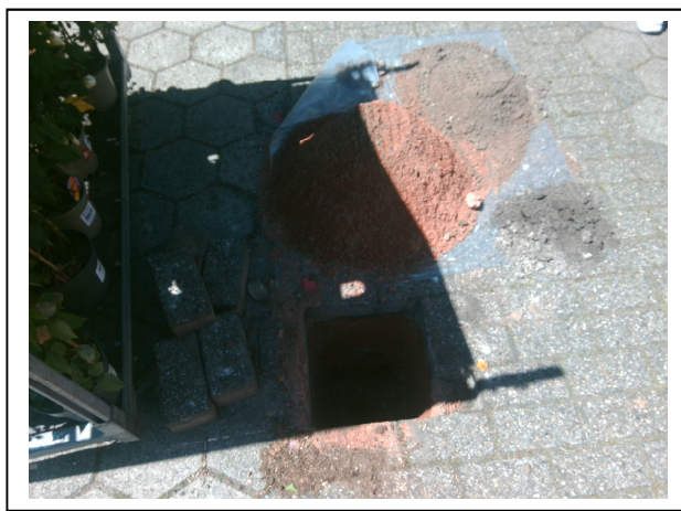
Foto6. Asbestinspectiegat A06
