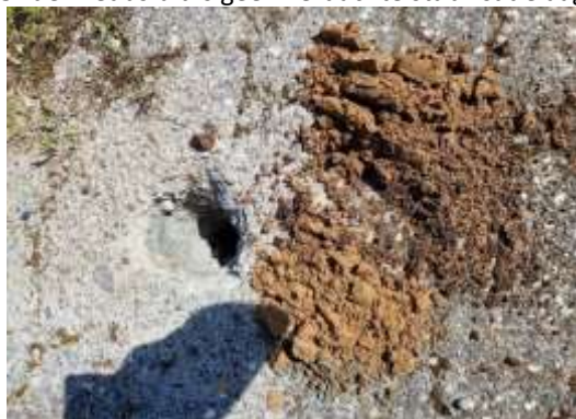
Figuur 13: Foto asfaltboring
