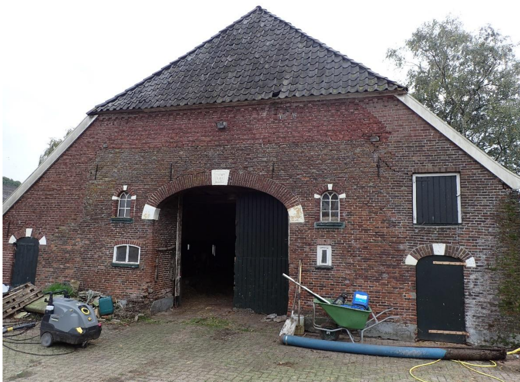
Figuur 13. Noordgevel van de boerderij, met de ingang van het bedrijfsgedeelte. In de gevel zijn talloze bouwsporen aanwezig die iets vertellen over de ontwikkeling van het gebouw sinds de bouw in 1826 (foto: RAAP, 14 oktober 2021).
