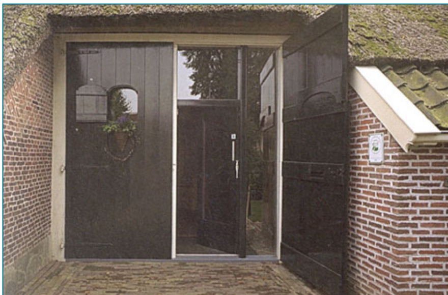
Verbouw van het oorspronkelijke hoofdgebouw
