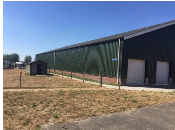
Figuur 9: Asbestvrije golfplaten.
