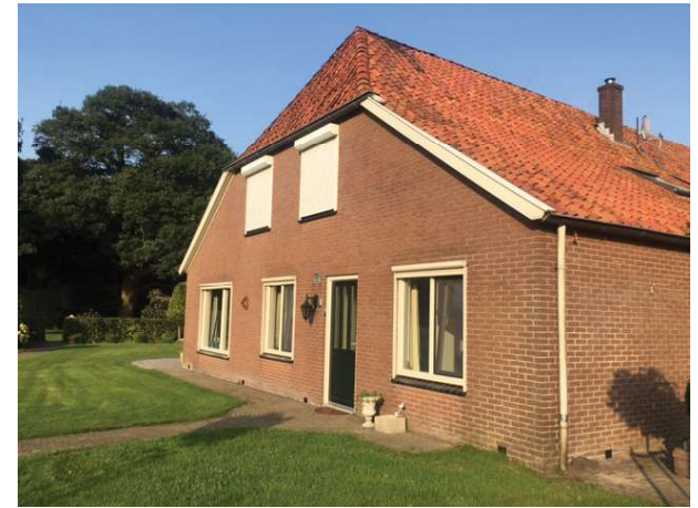
De karakteristieke woning met afgewolfd dak
