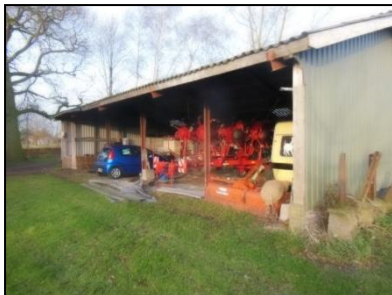
Figuur 3. Open kapschuur
