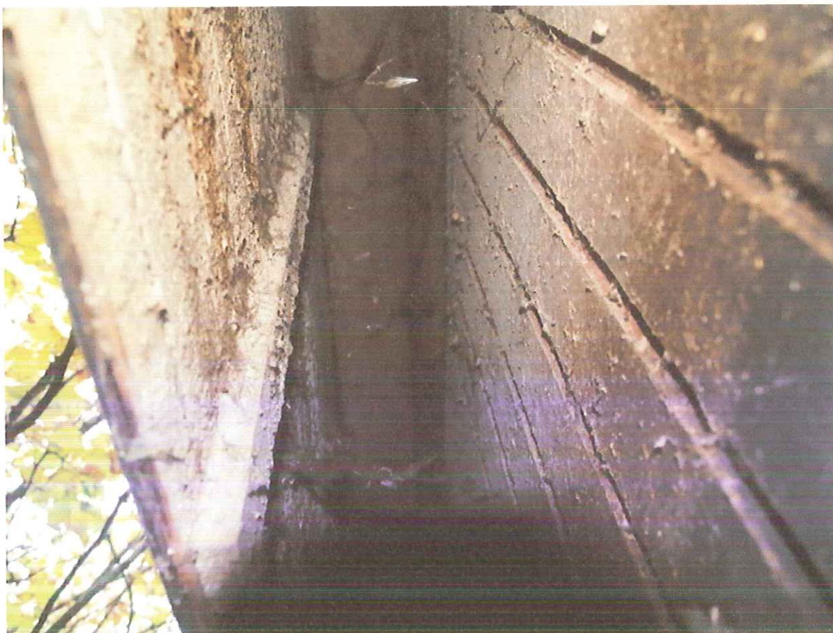
Afb. 4. Detailopname van een ventilatiekap. Deze zitten langs de volledige zijkant van de houten varkensstallen. Deze kappen zijn onderzocht op de aanwezigheid van vleermuizen. Deze zijn niet aangetroffen.
