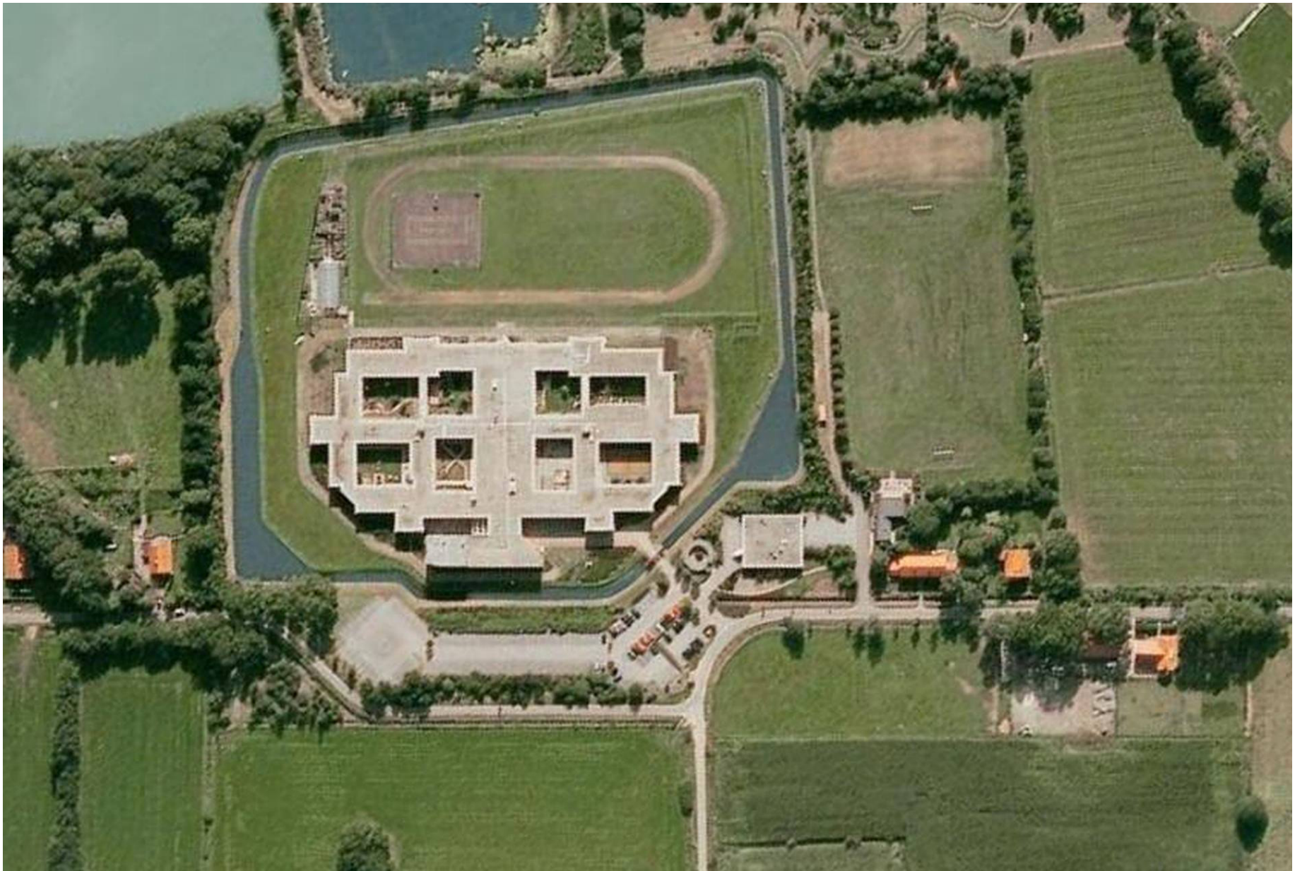
FPC Oldenkotte Rekken, luchtfoto
